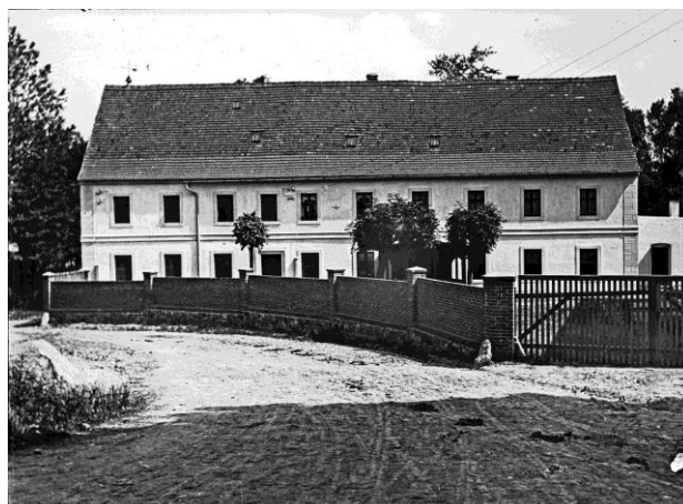
Ehem. Mahlmühle vor 1914 (SLUB)
